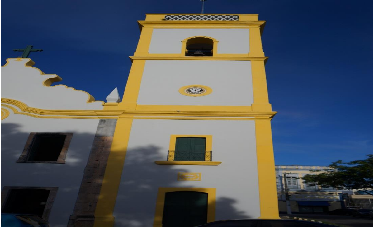
Figura 19 - Torre Sineira da Igreja Nossa Senhora da Apresentação
