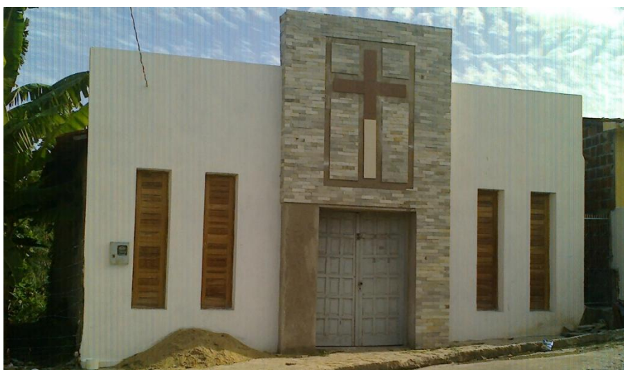
Imagem 5: Vista da nova fachada externa da Comunidade durante a reforma - 2015.
