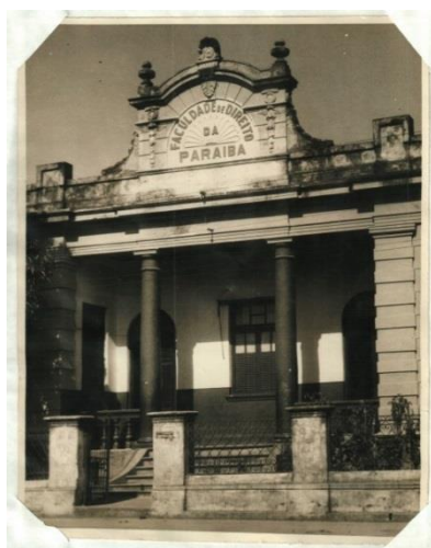
Figura 25 – Fachada da Faculdade de Direito – 1951-1953
