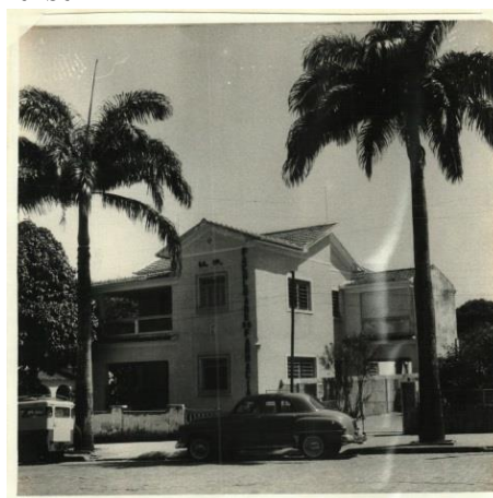
Figura 39 – Fachada da Faculdade de Farmácia da Paraíba
