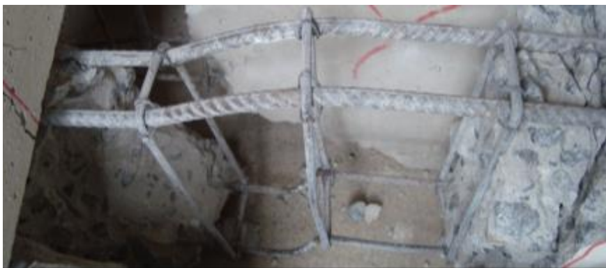
Figura 61 - Processo de dobradura em corte das armaduras
