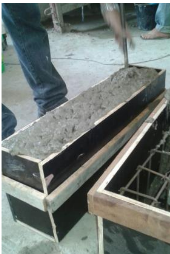
Figura 11 - Moldagem e adensamento das vigas
