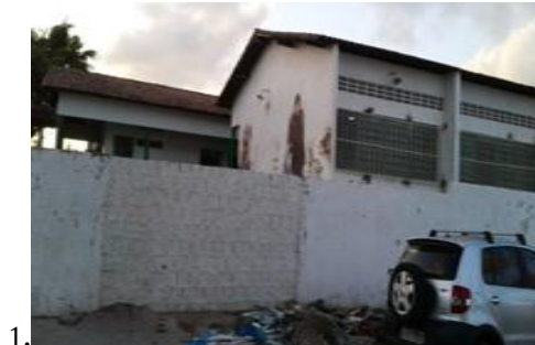
Muro lateral da escola - Fonte: Dados da pesquisa 2016
