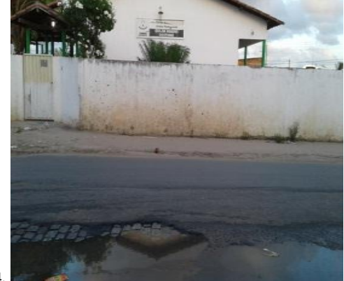
Fonte: Dados da pesquisa 2016 - Falta de saneamento básico-frente à escola
