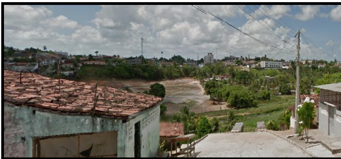
Foto 32 – Visão da Rua Napoleão Laureano, mostrando um dissipador de água. (Imagem capturada no Google Maps, 08/11/14).
