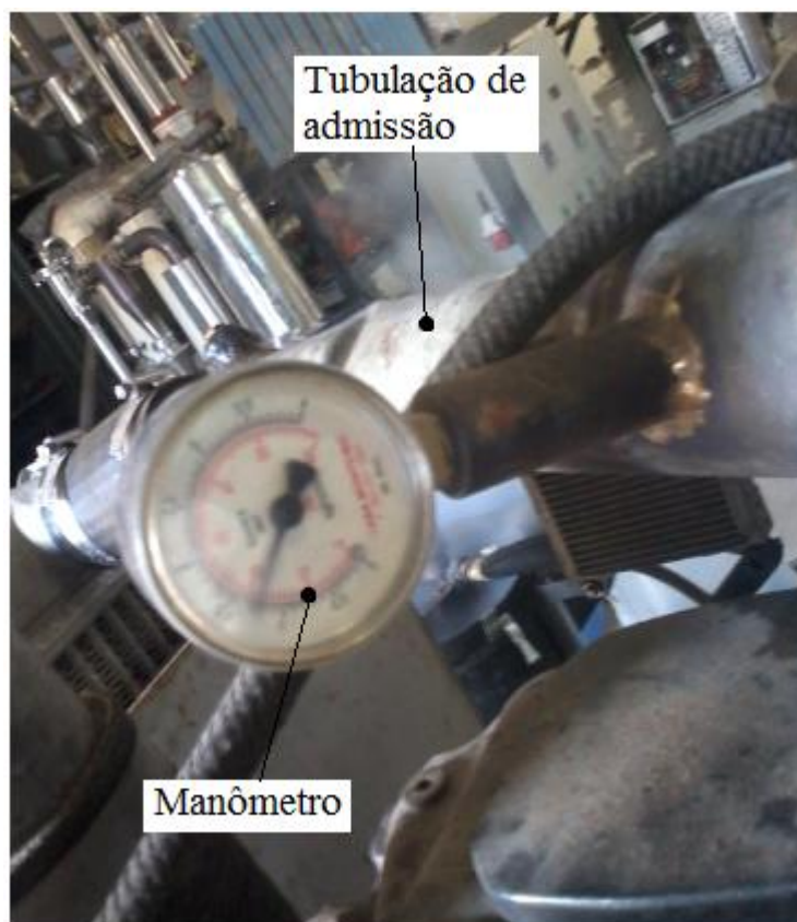
Figura 5.13 - Instalação do manômetro na tubulação de admissão.
