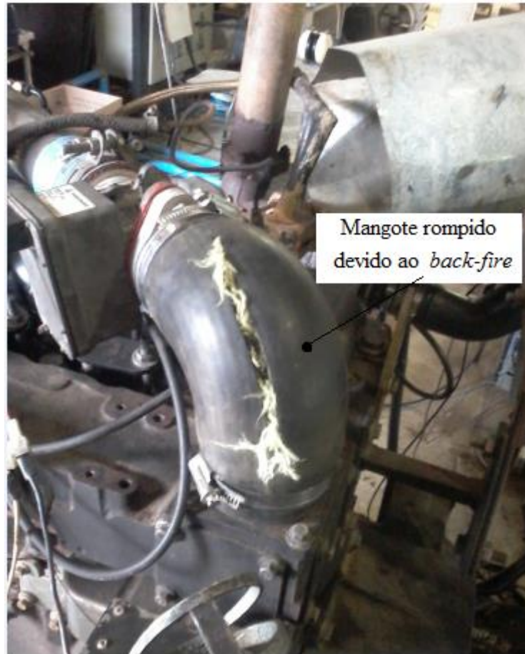
Figura 5.19 – O mangote rompido pela ocorrência de back-fire.
