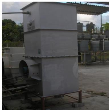
FIGURA 3.8 – TORRE DE RESFRIAMENTO DO CONDENSADOR
