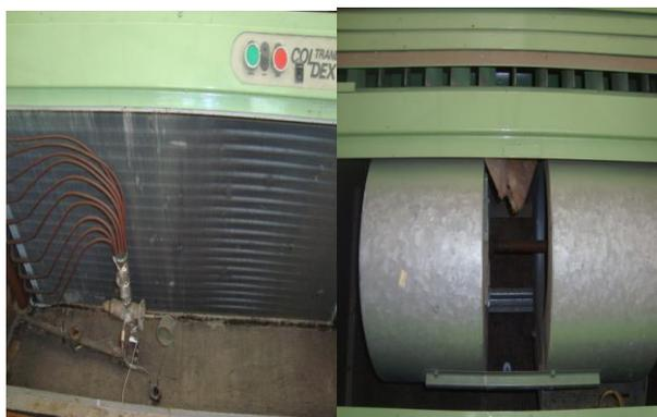
Figura 3.6 - Evaporador de serpentina de placas.
