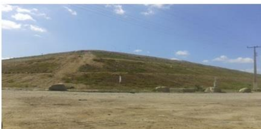
Figura 27 - Trincheira e Método de área no aterro do ASMOC
