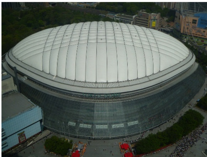
Figura 3 – Vista do estádio FONTE: The Arizona Republic (2012)
