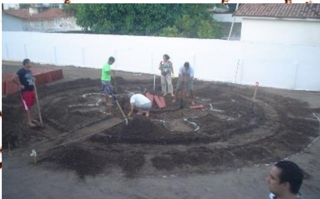
Figura 19. Fotos da construção do espaço da mandala central em 2012 Fonte: Pereira e colaboradores (2015).
