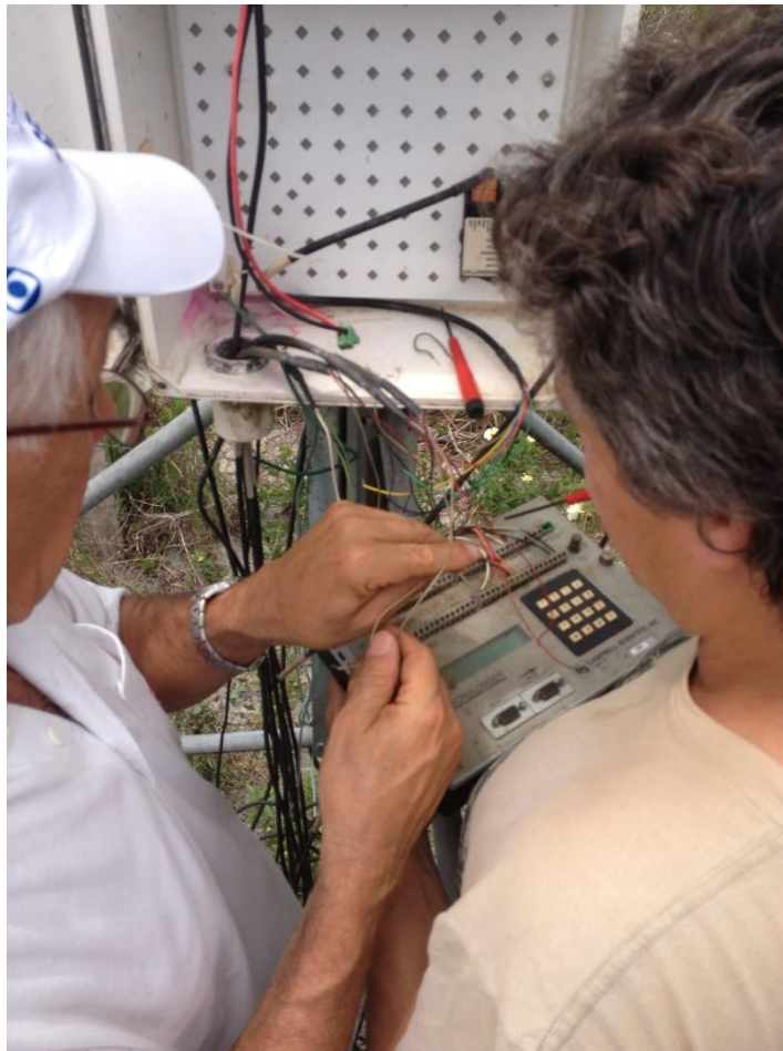
Figura 8 – Manutenção das estações de estudo
