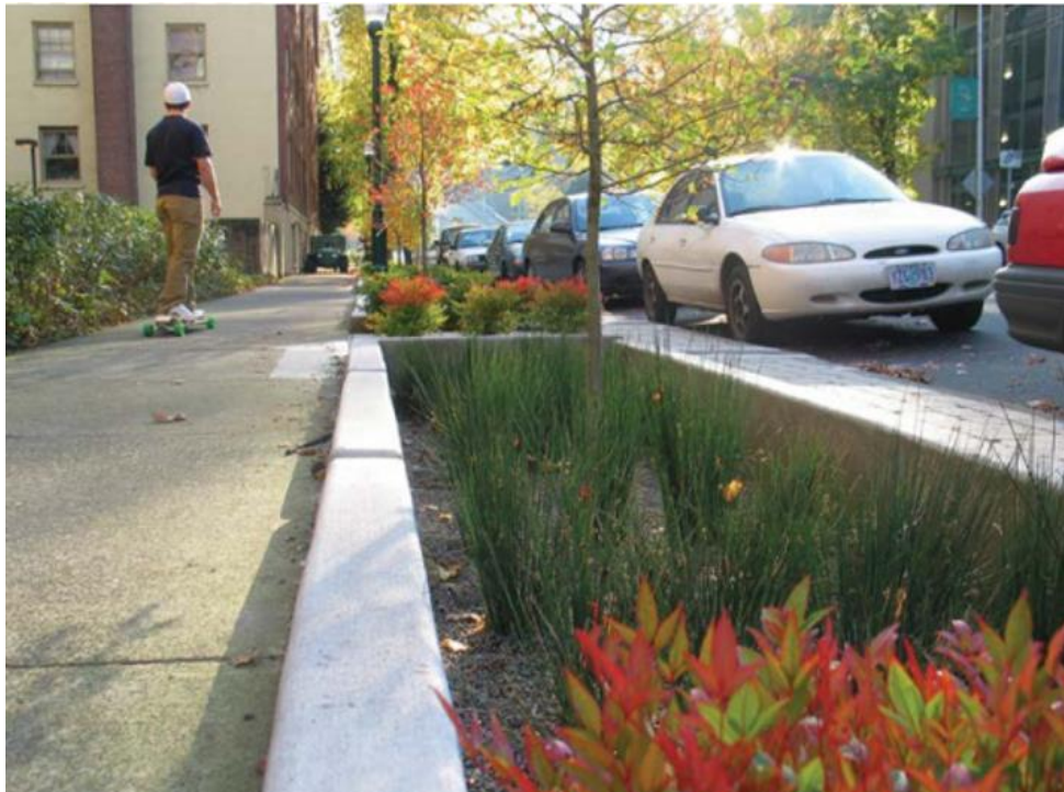
Figura 32 – Canteiros Pluviais no Bairro de Whiere Öst em Freiburg, Alemanha
