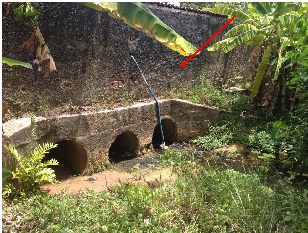
Figura 83: Muro lado Sul da AFRAFEP sob a passagem do rio Cabelo.
