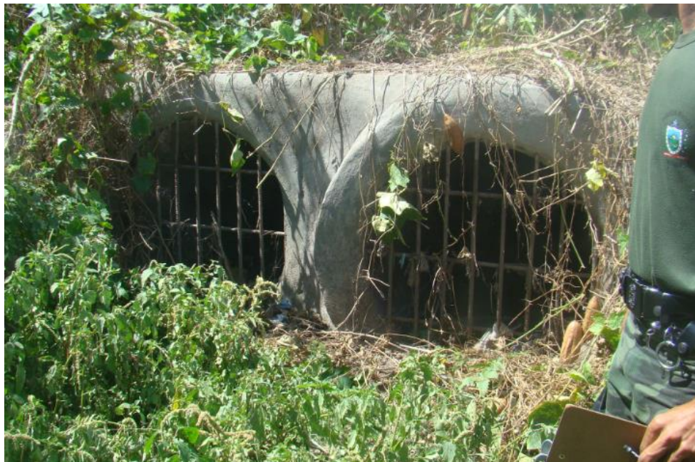
Figura 60: Galeria pluvial próximo a nascente do rio Cabelo.
