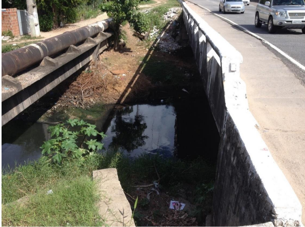
Figura 134– Ponte Desvio Shopping – Estação de Coleta 6.
