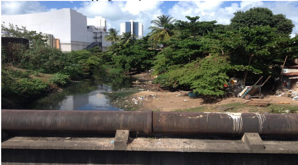
Figura 135 – Ponte Desvio Shopping – Estação de Coleta 6.
