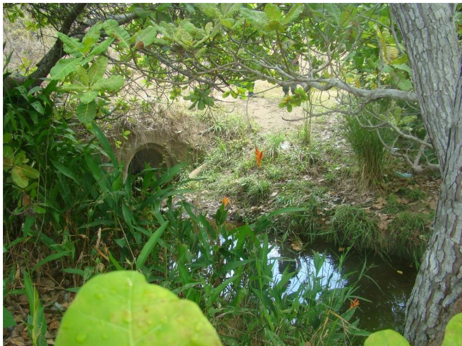
Figura 89: Curso do rio Aratu preservado – Estação de coleta 2 – Detalhe para tubulação de passagem do rio, por baixo da PB 008.
