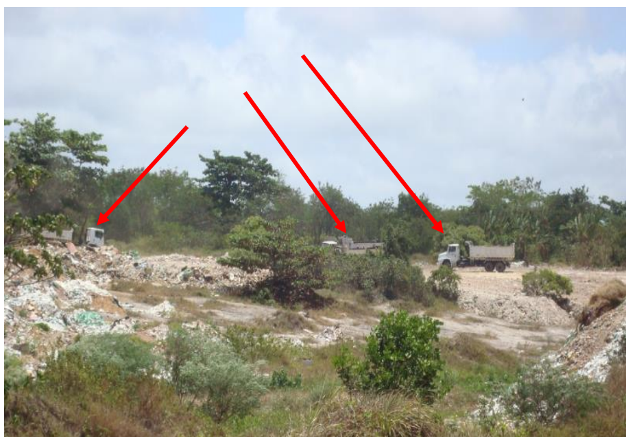
Figura 76: Evidências de degradação ambiental na mata das proximidades do rio Cabelo – Caminhões descarregando resíduos de construção.
