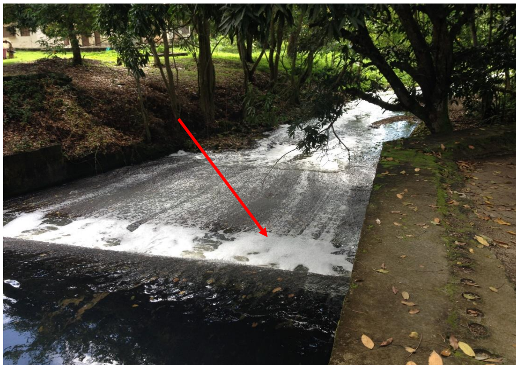
Figura 115 – Estação de Coleta 2 – Mata do Buraquinho – Destaque para a espuma proveniente de produtos químicos na superfície do rio.
