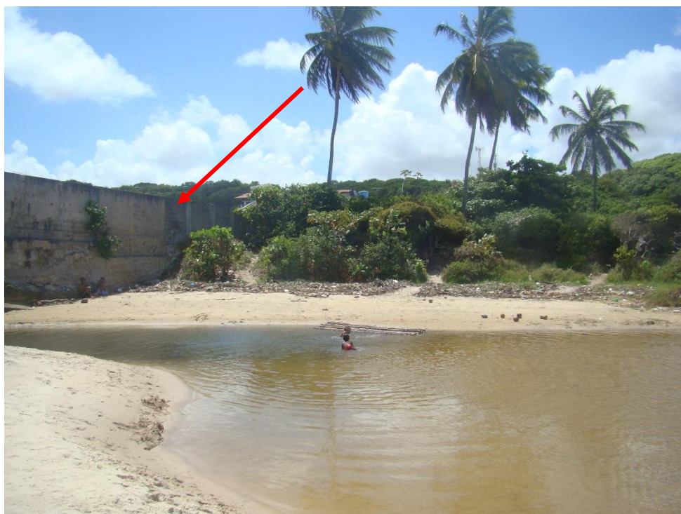
Figura 84: Muro lado Norte da AFRAFEP sob a passagem do rio Cabelo.
