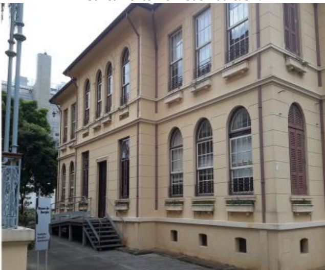
Figura 48 - Entrada do prédio do Núcleo De Documentação e Pesquisa da Fundação e Energia e Saneamento - em São Paulo/SP.
