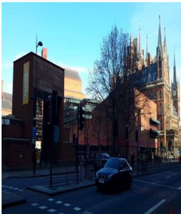
Figura 7 - Fachada da British Library , Londres.
