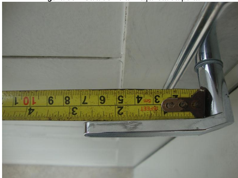
Figura 30 – Sala de Aula: maçaneta da porta.
