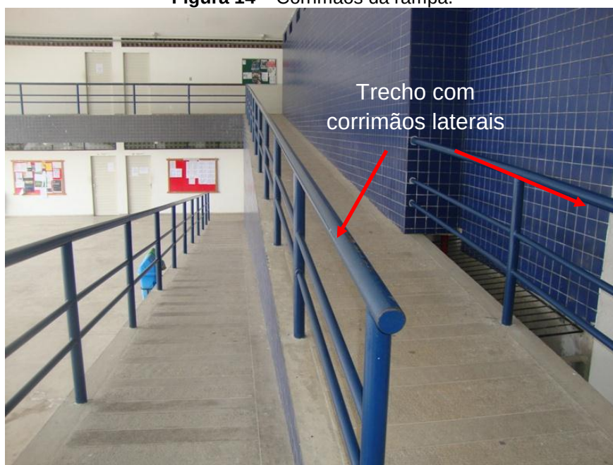
Figura 14 – Corrimãos da rampa.
