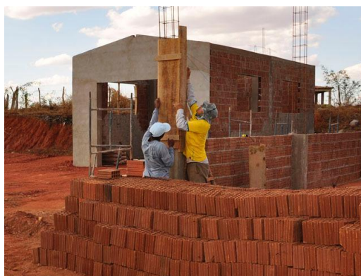
Figura 9 - Construção do galpão da associação
