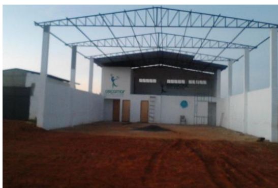
Figura 10 - Galpão da associação parcialmente finalizado
