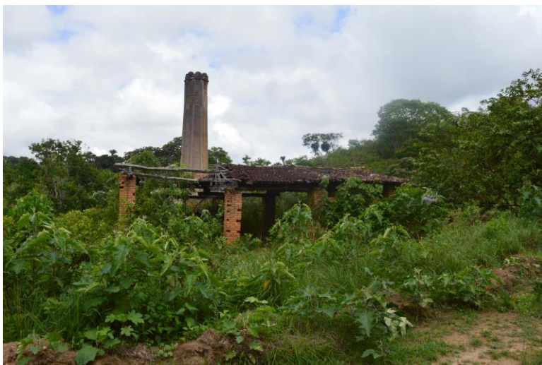
Figura 10 - Ruínas ocupadas pela vegetação existente no território quilombola
