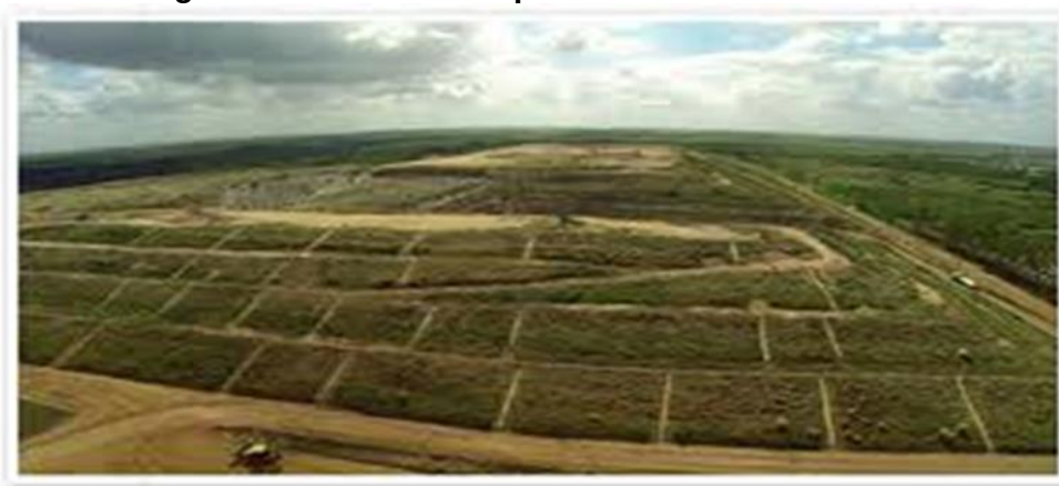
Figura 15 - Aterro Metropolitano de João Pessoa
