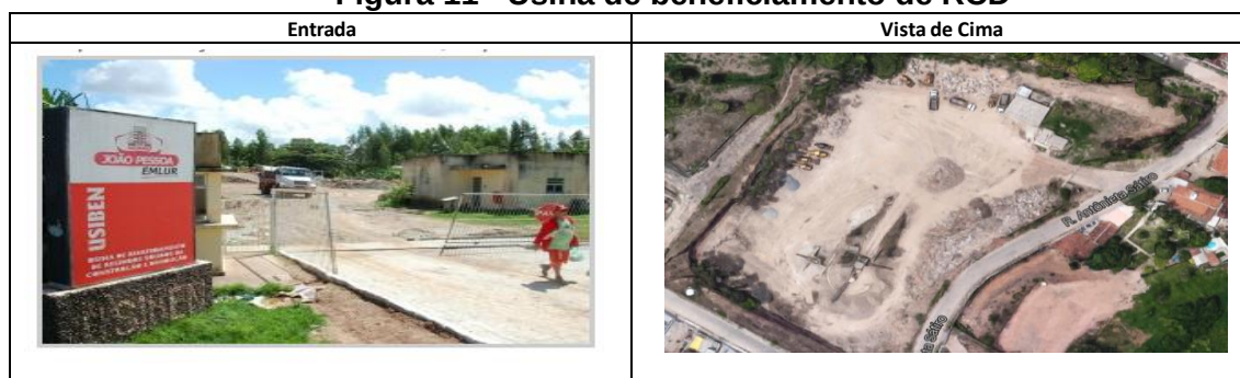
Figura 11 - Usina de beneficiamento de RCD
