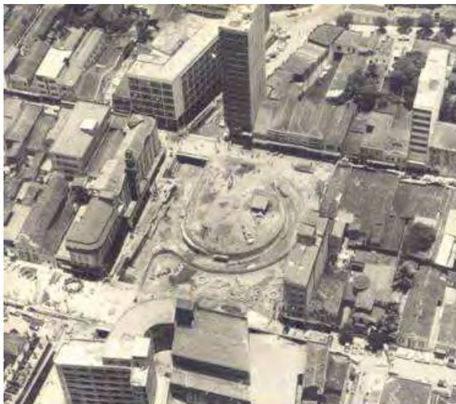
Figura 41 – Foto aérea do canteiro de obras do viaduto e da Praça Vidal de Negreiros
