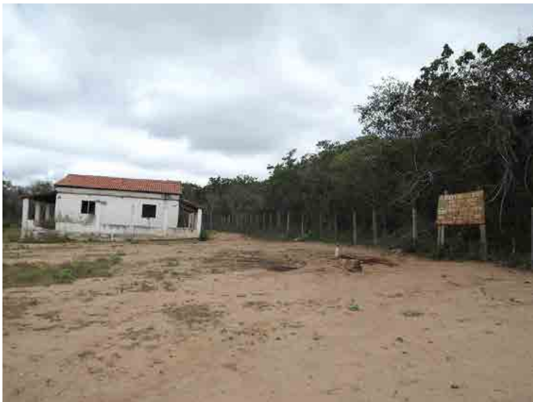
Figura 62: Vista de uma das casas da base de operações da REBIO Serra Negra, atualmente abandonada.
