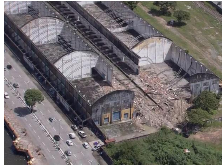
Escombros dos Galpões
