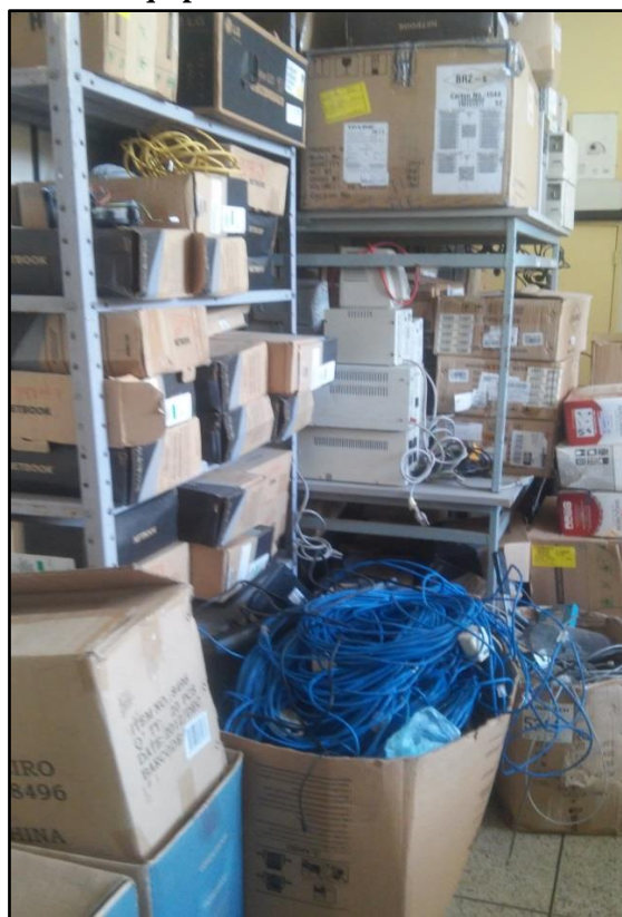
Figura 04: Sala de manutenção dos equipamentos – NTE – CG.
