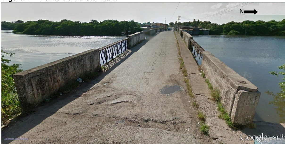
Figura 4 – Ponte do rio Sanhauá
