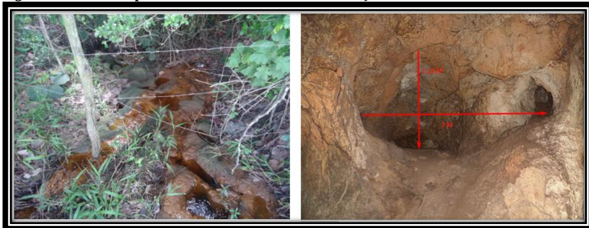
Figura 17 - Erosão superficial e interna na Caverna da Onça
