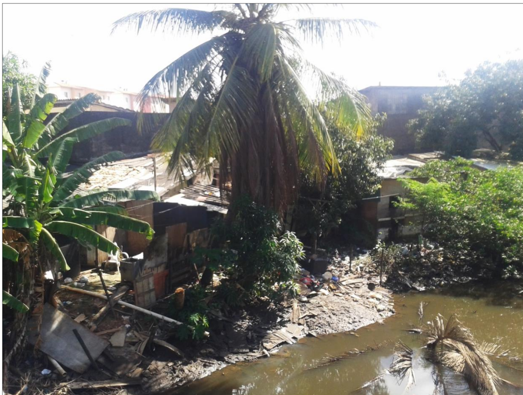
Fotografia 15 - Ocupação à margem do Rio Poxim próxima à ponte do Conjunto Santa Lúcia
