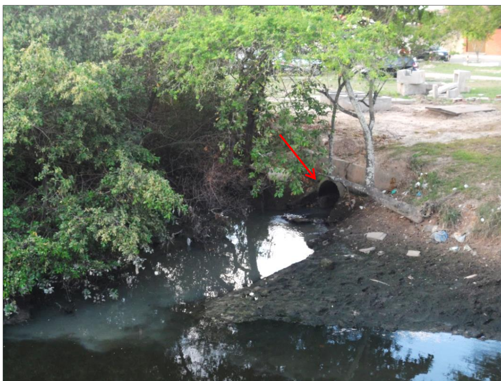
Fotografia 6 - Esgoto doméstico despejado sem tratamento no Rio Poxim
