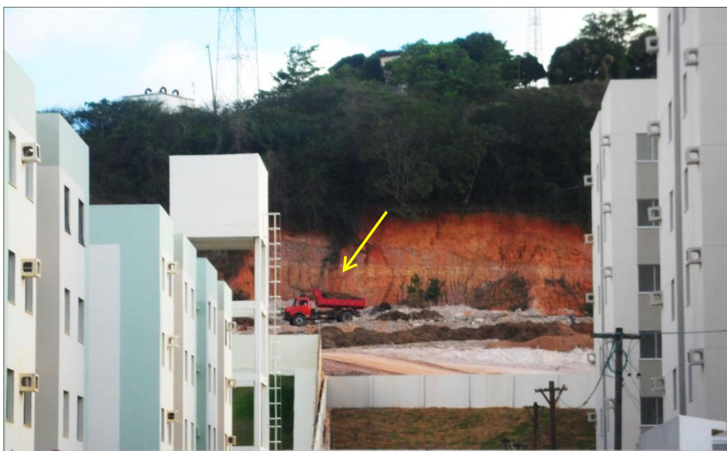
Fotografia 8 - Área de desmonte da Formação Barreiras
