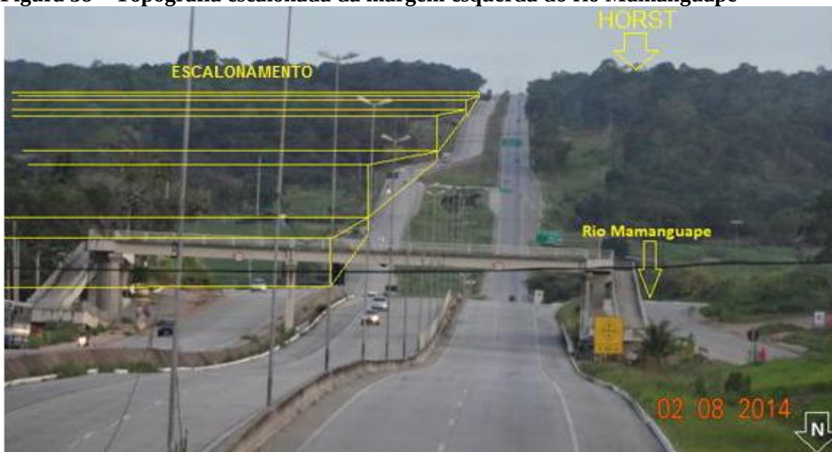
Figura 38 – Topografia escalonada da margem esquerda do rio Mamanguape
