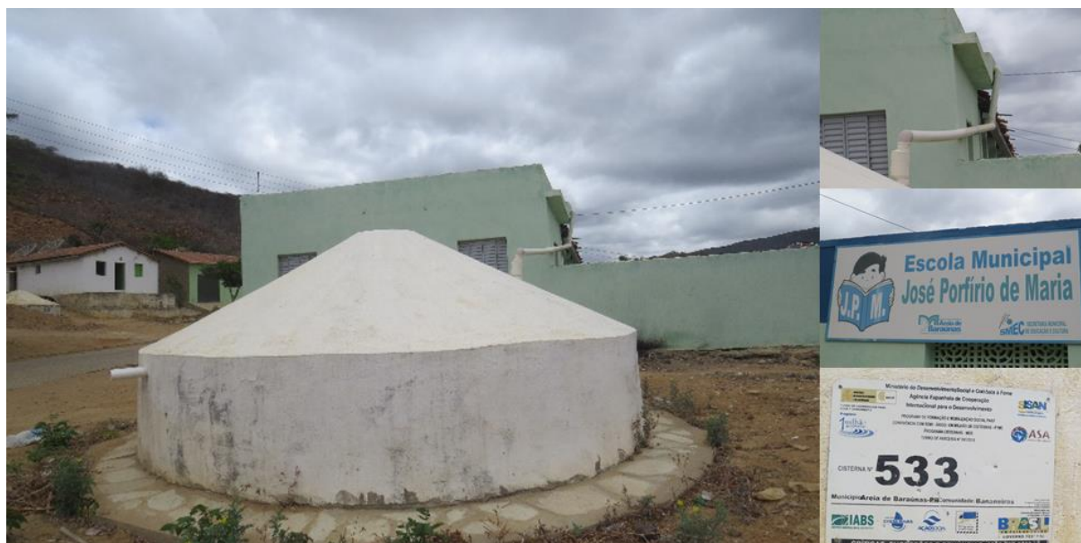
Figura 15: Cisterna construída pelo Programa Cisterna na Escola, em 2011, na comunidade Bananeiras, em Areia de Baraúnas.
