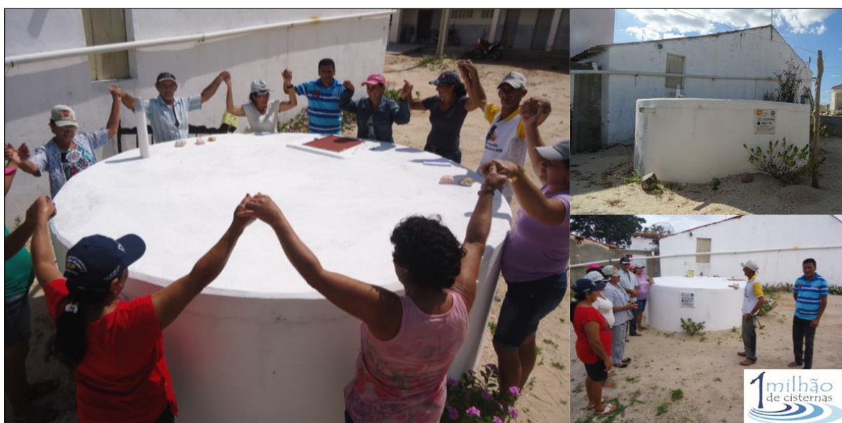
Figura 16: Cisterna de placas com capacidade de armazenar 16 mil litros de água.
