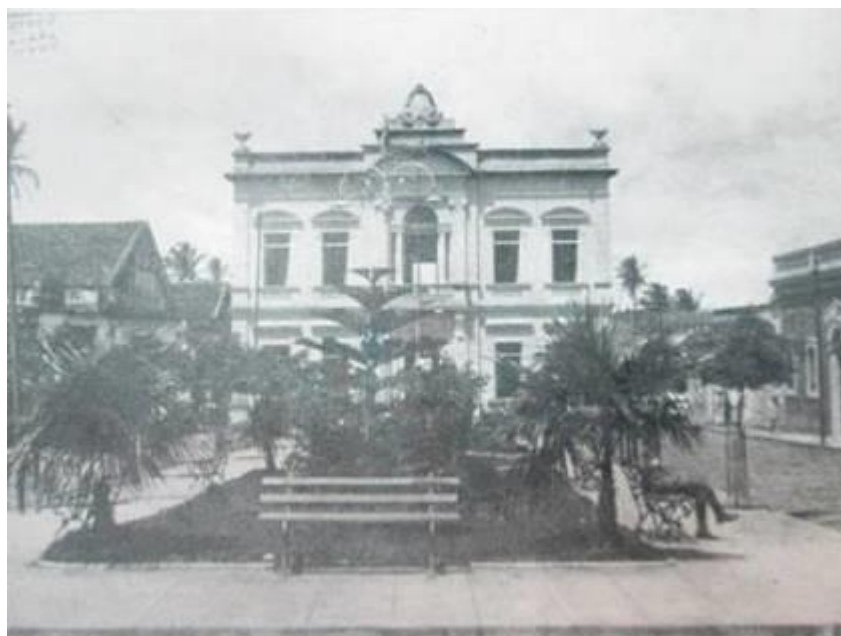
Foto 2 - Prédio do Palácio do Tesouro, Praça Rio Branco, onde funcionou entre 1912 - 1929 a Assembleia Legislativa do Estado da Paraíba e local da Exposição Estadual do Centenário. Fonte: Revista Era Nova . (1922, s/p).
