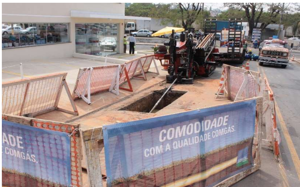
Figura 22 - Obra da COMGÁS utilizando MND em vias urbanas
